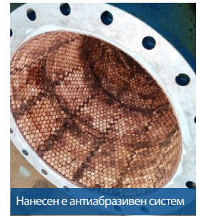
Обновување на внатрешната површина
