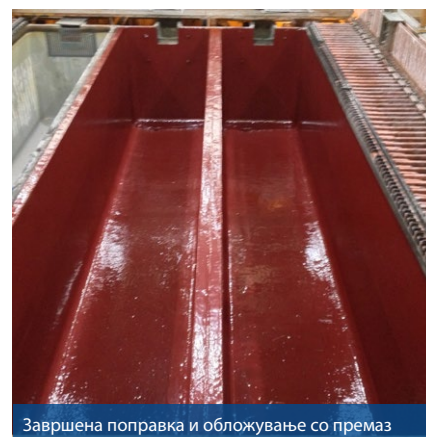
Завршена поправка и обложување со премаз
