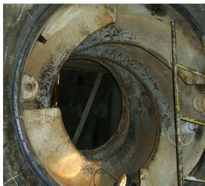
Спирала (чаура) подготвена да биде задихтувана
