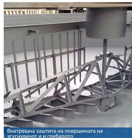
Завршена поправка и обложување со премаз
